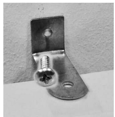
nu tillbaka radiatorn igen och skruva fast bygeln så som visas på bilden. Radiatorn är nu monterad.
